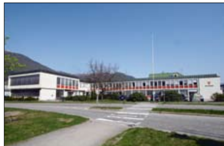
Rådhuset i Eid kommune er et av byggene som har vært med i nettverksprosjektene. Bygget er tilknyttet fjordvarmenettet.
